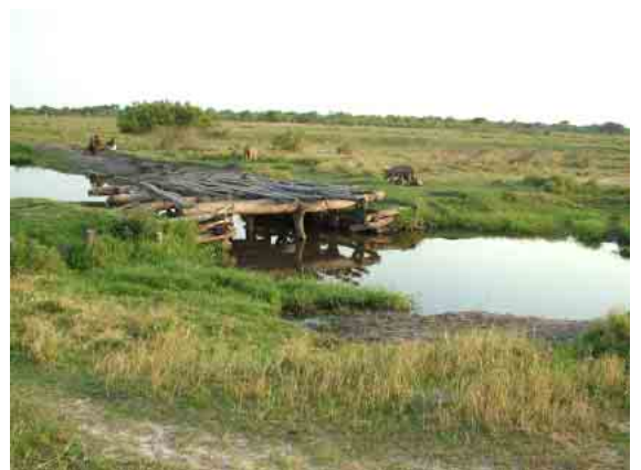
Zerstörte Brücke über den Lueti
